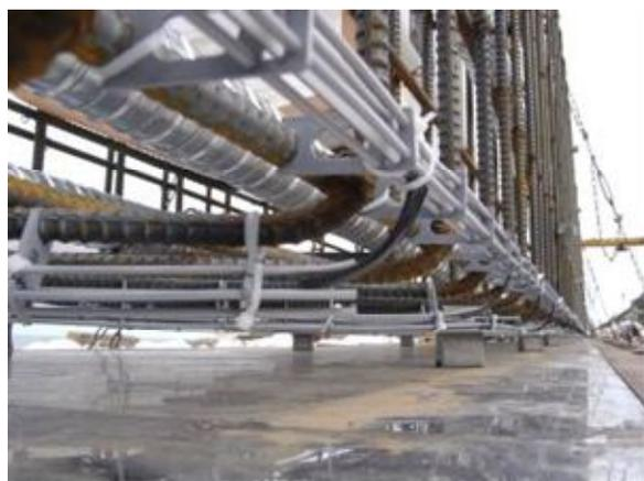
写真-10 リボンメッシュの新設構造物への適用
