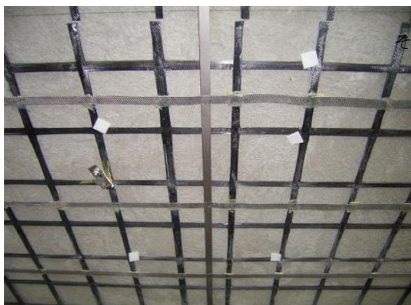
写真－21 補強併用電気防食用陽極の設置状況
