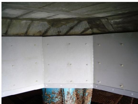
写真-8 永久型枠方式の電気防食の施工完了状況
