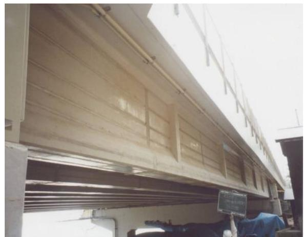
写真-17 橋梁へのチタンリボン方式の適用例
