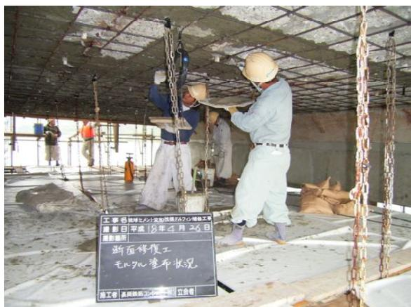
写真－20 置き換え鉄筋の設置状況
