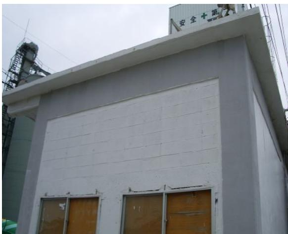
写真-16 電気防食施工後15年目の状況（2006年）
