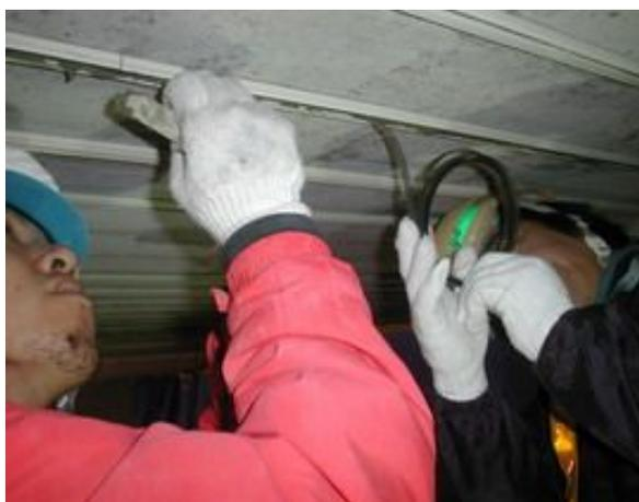
写真-11 モールド方式チタンリボンの施工状況
