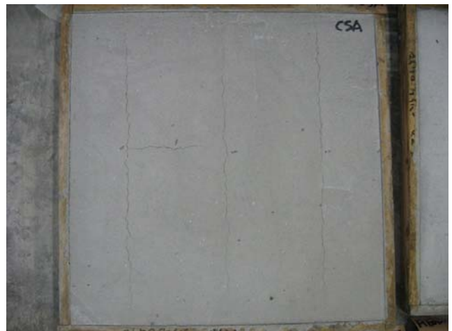
写真-8 CSA 配合のひび割れ発生状況
