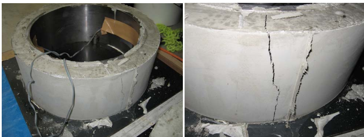
写真-3 Plain 配合のひび割れ状況
