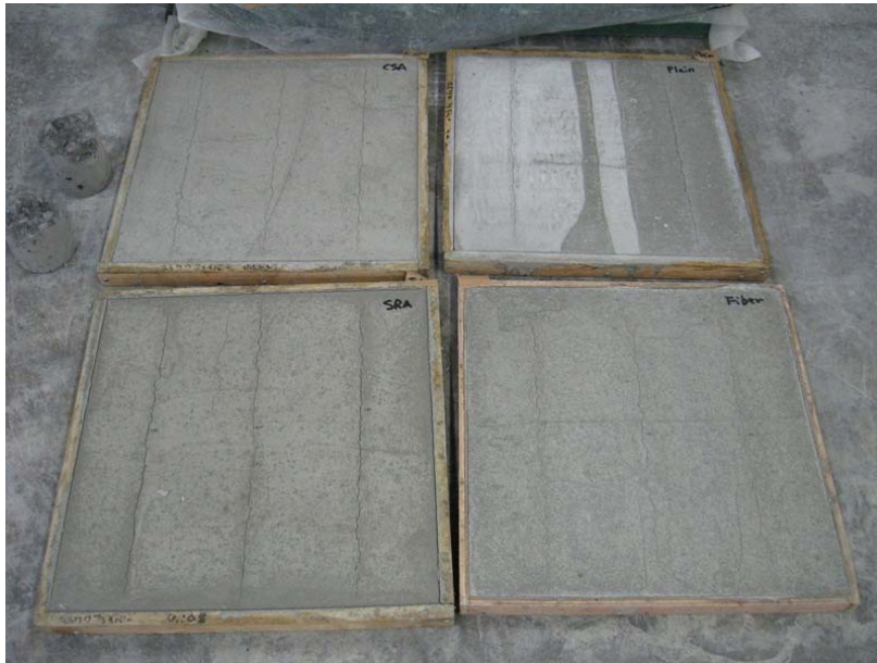
写真-6 ひび割れ発生状況(全配合, 材齢 1 日)
