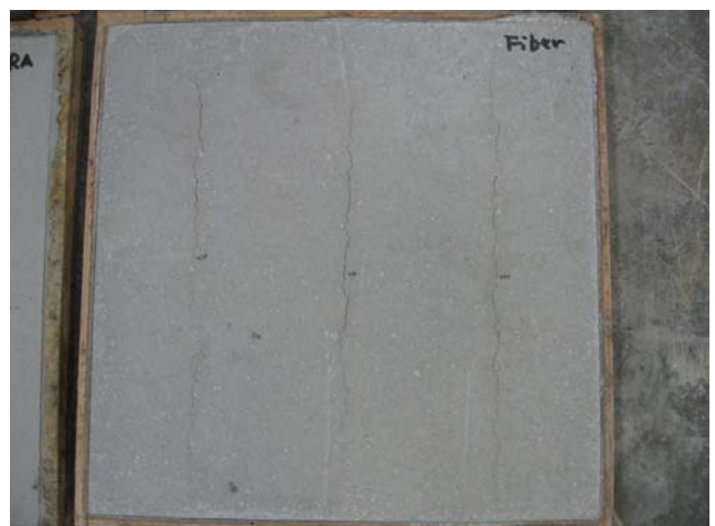
写真-10 Fiber 配合のひび割れ発生状況
