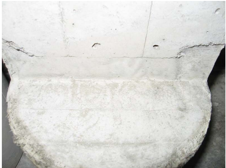
写真-1 沈下ひび割れ試験 脱型後の状況 (Plain 配合)
