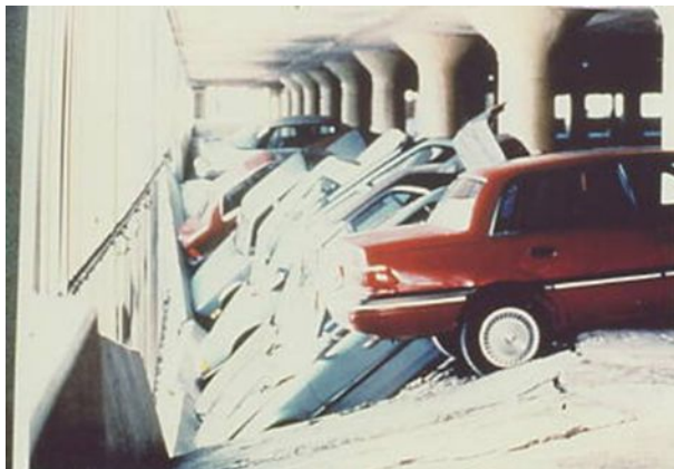
写真-3 米国の駐車場の塩害による崩落事故
