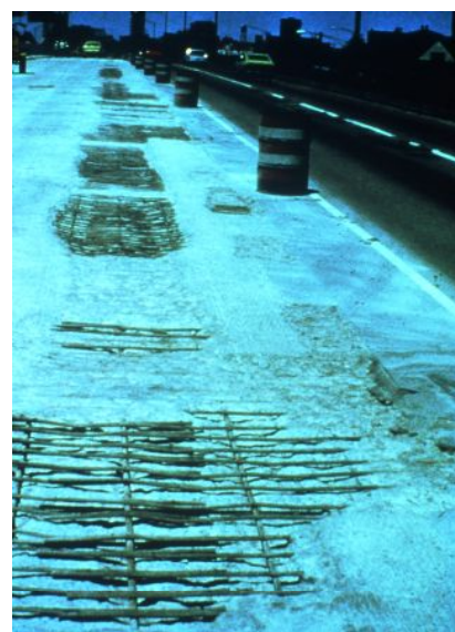
写真－1 米国における道路上面の塩害劣化損傷
