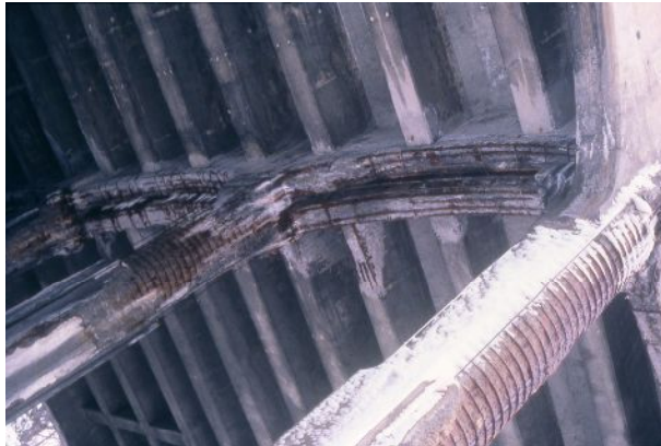
写真-2 米国における橋梁下面の塩害劣化損傷
