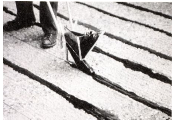
写真-5 溝式ノンオーバーレイ方式の電気防食
